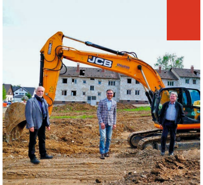
Spatenstich „An der Oberen Halde“, 3. Bauabschnitt, Mai 2020
