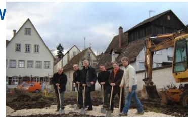
Spatenstich Rinderbacher Gasse
