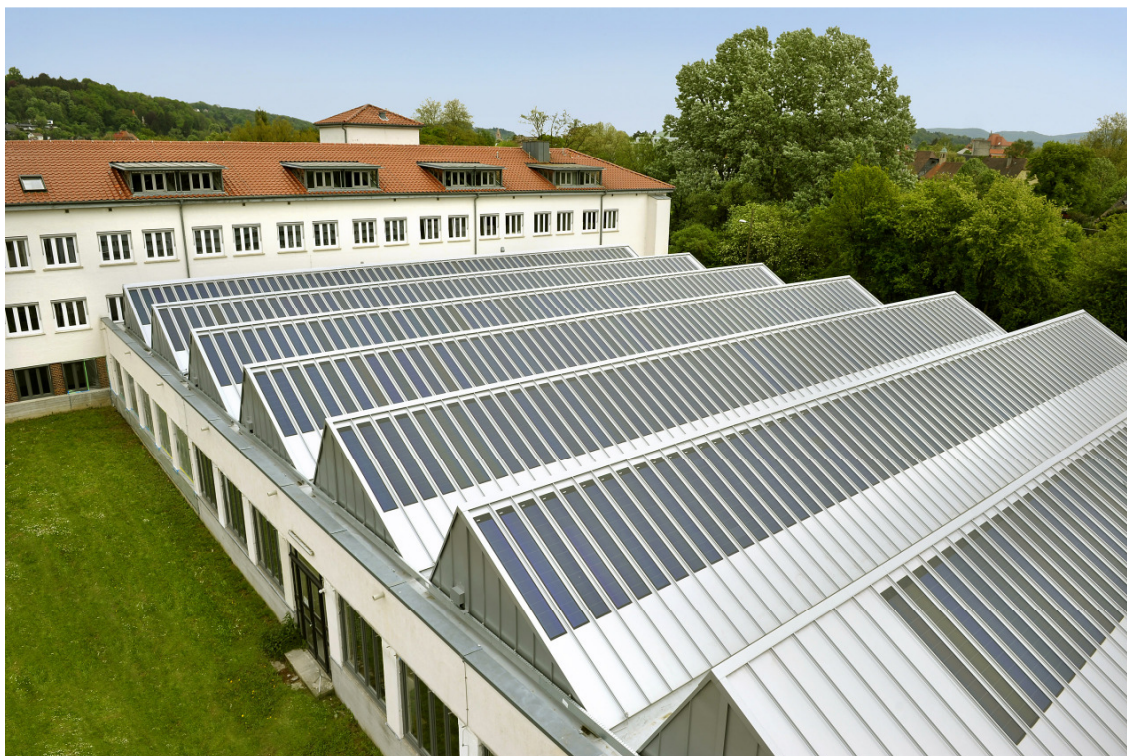
Shedhalle im „Zapp“ mit Photovoltaikmodulen
