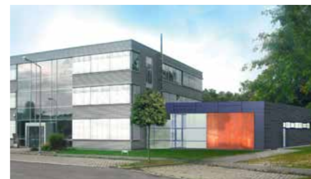
8 Qubus/Ifo Anbau Technikumsgebäude ca. 330 m 2
